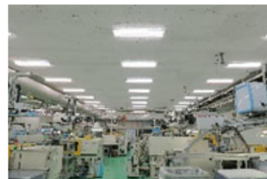
山形カシオ工場のLED照明
